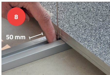
Single Paneele auslegen und die Nutensteine fixieren
