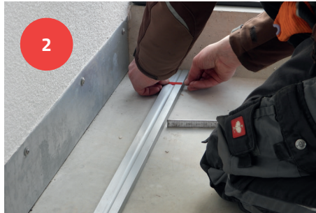
Unterkonstruktionsschiene bekleben und ausrichten
